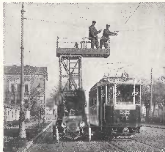
Heranziehung der Oberleitung während des Betriebes
