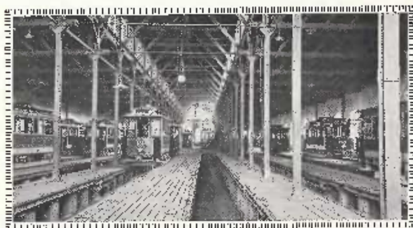
Wagenhalle mit Dachstuhl aus Holz im Bahnhof Bismarckheim
